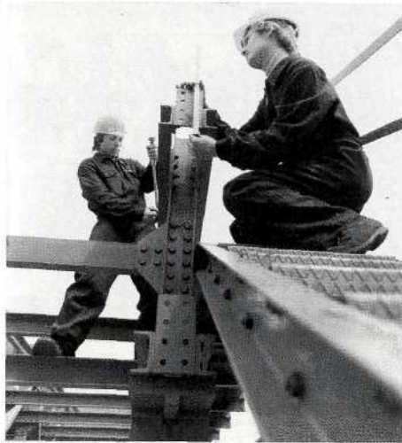
Stahlbau-schlosserlehrlinge bei Montage einer Brückenkonstruktion. Foto: VOEST-Alpine AG
