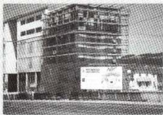
1995: Das Ars Electronica Center noch im Rohzustand.
